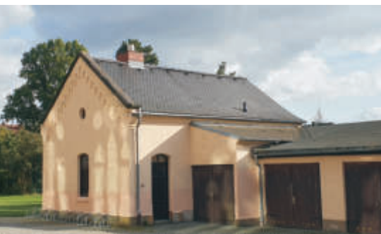
Heizhaus im Oktober
